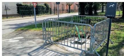
Réalisation d'un plot béton en vue de l'installation d'un nouveau panneau lumineux au rond-point avenue Claude Chappe
