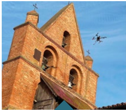
DÉMOUSSAGE PAR DRÔNE Du toit de l'Église
