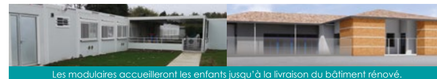
Les modulaires accueilleront les enfants jusqu'à la livraison du bâtiment rénové.
