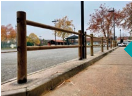
SÉCURISATION DU TERRAIN DE PÉTANQUE Espace Marcel Clermont
