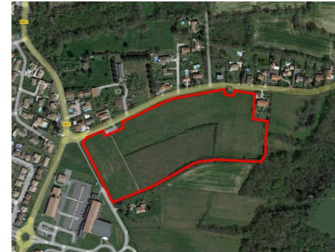
Photo aérienne d'Août 2022 (source : Géoportail)
