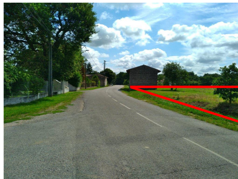
Figure 15 : Vue de la route de la Poumayre vers le Nord-Est du site
