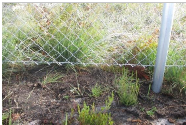
Figure 57 : Exemple de clôture perméable © ETEN environnement
